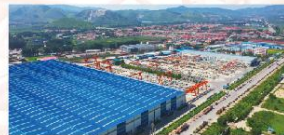
中国二十二冶集团有限公司 国家装配式产业基地
